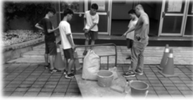
「自己的學校自己修」：土建工坊師生進行校園簡易修繕工程
